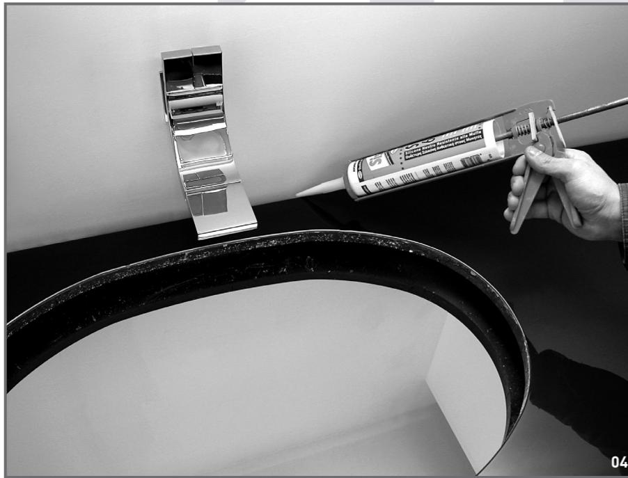
04 Nach Justierung der Ablage, rücken Sie diese leicht von der Wand ab, um dann über die gesamte Breite in die Fuge Silicon einzuarbeiten, damit die Ablage zur Wand hin versiegelt und abgedichtet wird.
