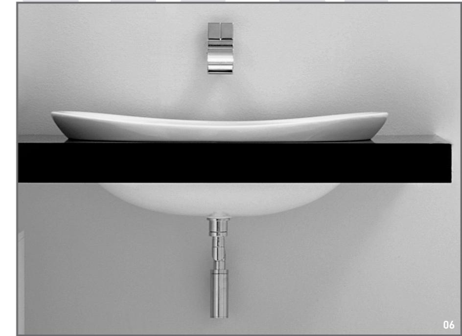
06 Warten Sie bis das Silicone ausgehärtet ist, bevor Sie den Ablauf und die Armaturenanschlüsse endgültig verbinden, um eine korrekte und genaue Installation zu gewährleisten.
