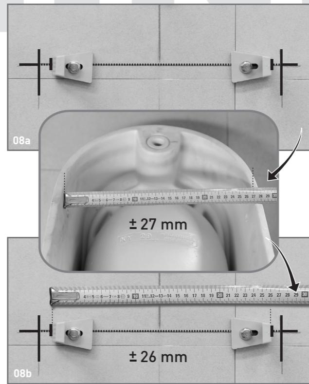
08 Fissaggio delle staffe: bloccare le due staffe come da foto [08a]. Rilevare la misura interna del sanitario ( $\pm 27$  mm) e successivamente verificare che la distanza fra le staffe sia inferiore di circa 10 mm ( $\pm 26$  mm) a quella rilevata. Dopodiché serrare bene le staffe nella posizione corretta.
