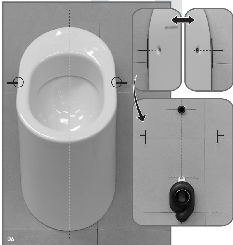
06 Vorereitung zur Installation des Urinal an der Wand. Zeichnen Sie die Außenposition der Befestigungslaschen an der Wand an, nachdem Sie den Siphon und Zulaufgummiverbinder mit Gleitmittel eingestrichen haben.
