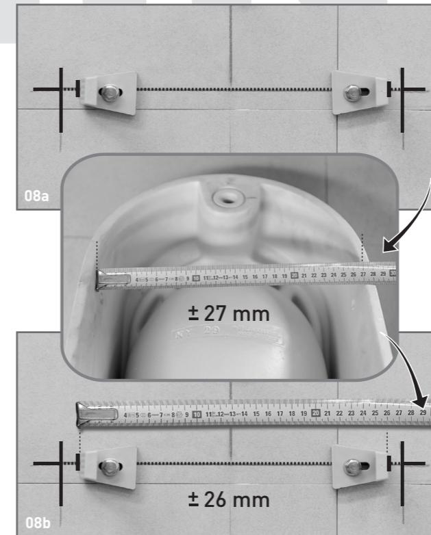
08 Montage der Befestigungslaschen. Schrauben Sie die Laschen an die Wand (08a). Nehmen Sie das Innenmaß des Urinal ( $\pm 27\text{mm}$ ) und überprüfen dann, das der Abstand zwischen den Laschen höchstens 10mm weniger ist als das Innenmaß des Urinal. ( $\pm 26\text{mm}$ ) Ziehen Sie die Schrauben der Befestigungen nach Einrichten fest an.
