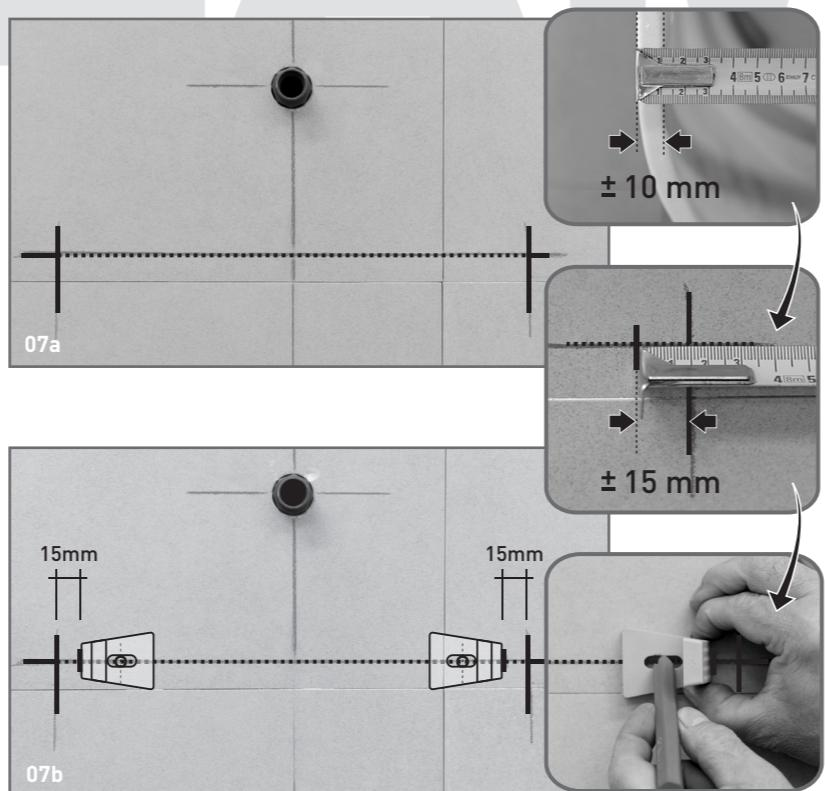
07 Preparazione al fissaggio delle staffe: tracciare l'allineamento dei fori di fissaggio [07a]; rilevare lo spessore della ceramica ( $\pm 10$  mm) riportare la misura maggiorata ( $\pm 15$  mm) sulla parete; quindi con la staffetta in plastica segnare la posizione dei fori per il fissaggio.
