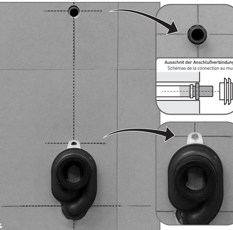
04 Installation des Zu- und Ablaues. Schrauben Sie den Zulaufverbinder ein, stellen Sie dabei jedoch sicher das dieser fest in der Wand eingeschraubt ist, wie im Bild dargestellt. Verbinden Sie den Siphon mit dem Ablauf in der Wand. Markieren Sie die Position des Loches, verwenden Sie dazu den Siphon als Schablone. Ziehen Sie die Schraube nach Ausrichten des Siphon fest.
