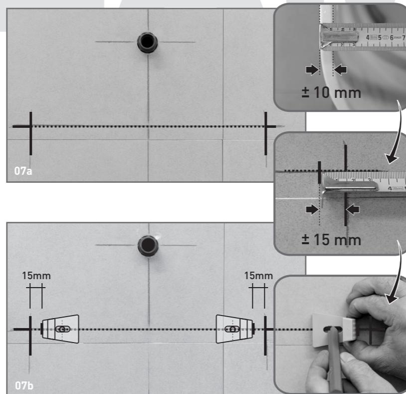
07 Vorbereitung zur Befestigung der Laschen. Zeichnen Sie die Bohrungen für die Laschen an (07a). Messen Sie die Stärke der Keramikwandung des Urinales ( $\pm 10\text{mm}$ ) und zeichnen danach die Stärke an der Wand an ( $\pm 15\text{mm}$ ). Danach verwenden Sie die Laschen als Schablone um die Bohrungen anzulegen.
