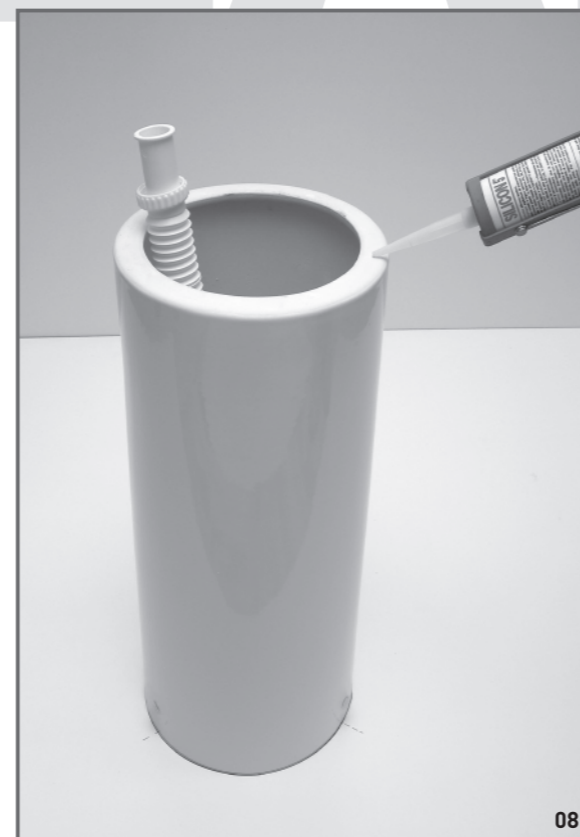
08 Préparation pour la fixation du lavabo à la colonne: recouvrir le bord de la colonne avec du silicone. Waschbeckenbefestigung: Bringen Sie auf den oberen Rand der Säule Silicon auf.
