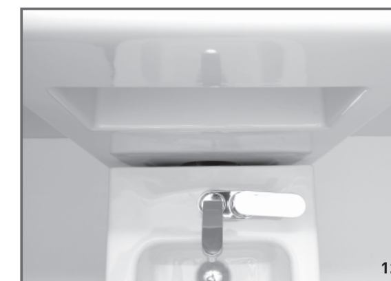
11-12 Installation du Réservoir Niagara: éloigner le bidet du mur (140 mm) mais faire attention au tube; accrocher encore le réservoir Niagara de haut en bas, pousser le bidet contre le réservoir et puis le fixer au plancher. N'utiliser pas de silicone pour fixer le bidet e le Réservoir. Installation der Niagara Abdeckung: Ziehen Sie das Bidet vorsichtig nach vorne auf eine Maß von 140mm von der Wand, achten Sie auf die Rohrverbindungen. Haken Sie die Niagara Abdeckung von oben nach unten in die Befestigungsglasche ein. Schieben das Bidet gegen die Abdeckung und verschrauben dieses dann am Boden.
