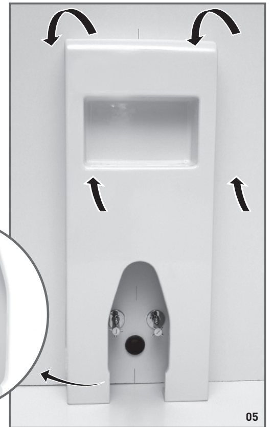
05 Installation du Réservoir Niagara: accrocher le de haut en bas. Vérifier la nécessité d'utiliser des flexibles pour brancher le robinet. Installation der Niagara Abdeckung: Haken Sie die Abdeckung von oben nach unten in der Befestigungsglasche ein. Beachten Sie die evtl. Installation von Flexschläuchen für die Armatur.
