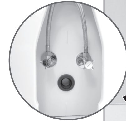
05 Installation du Réservoir Niagara: accrocher le de haut en bas. Vérifier la nécessité d'utiliser des flexibles pour brancher le robinet. Installation der Niagara Abdeckung: Haken Sie die Abdeckung von oben nach unten in der Befestigungsglasche ein. Beachten Sie die evtl. Installation von Flexschläuchen für die Armatur.
