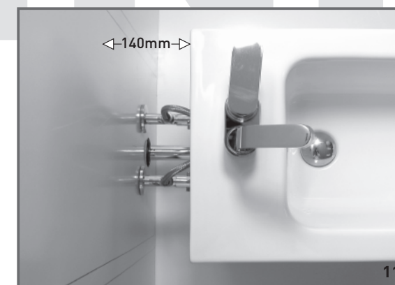
04 Fissaggio della staffa di sostegno: rispettare l'altezza indicata della staffa da terra. Predisporre gli allacci acqua calda e fredda tramite rubinetti filtro e l'allaccio scarico bidet con morsetto in gomma. Fixing the bracket: fix it at standard heights. Install hot & cold water tap filters and the bidet outlet using the rubber holdfast.
